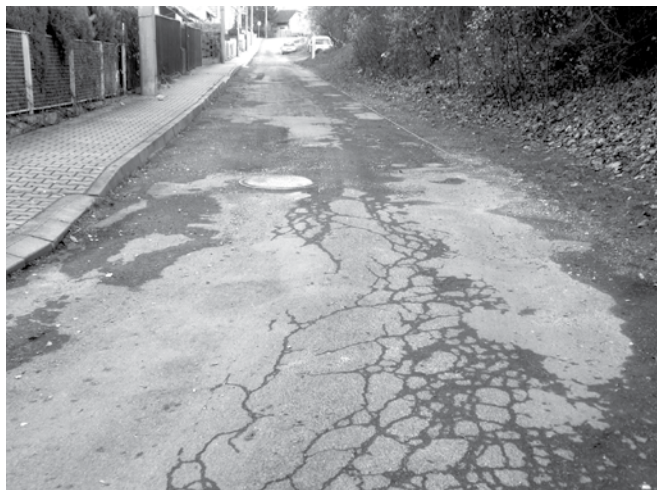
Rok 2015 před rekonstrukcí
