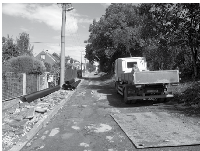
V průběhu rekonstrukce
