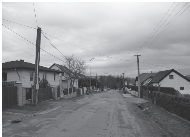
Roztocká ulice před rekonstrukcí
