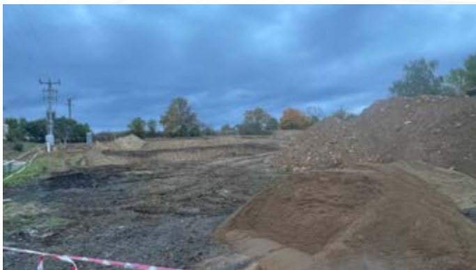
V současné době probíhá skrývka ornice. (Zdroj: autor)
