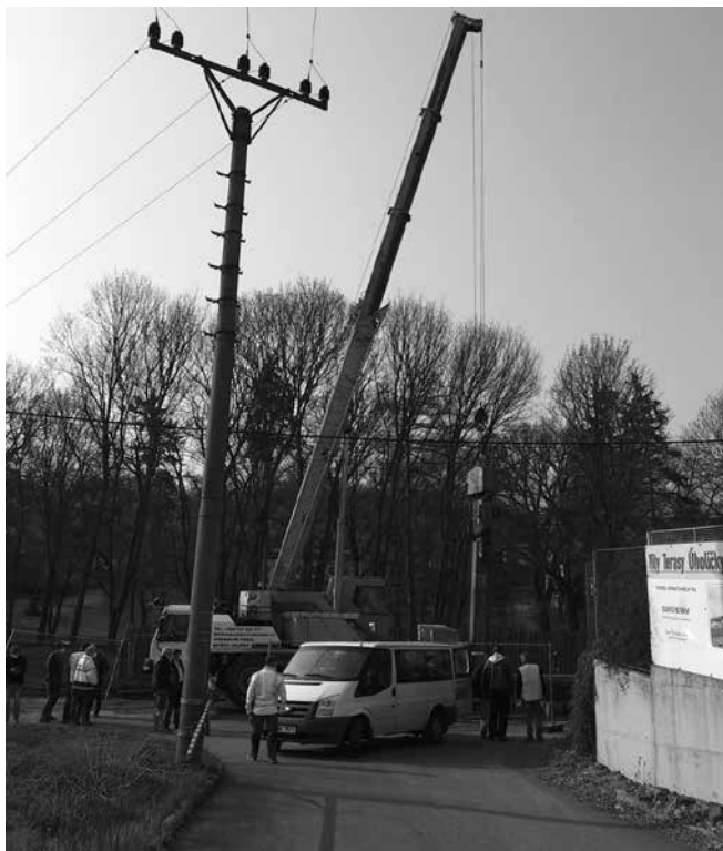
Oprava propadlé opěrné zdi a silnice do Velkých Přílep
