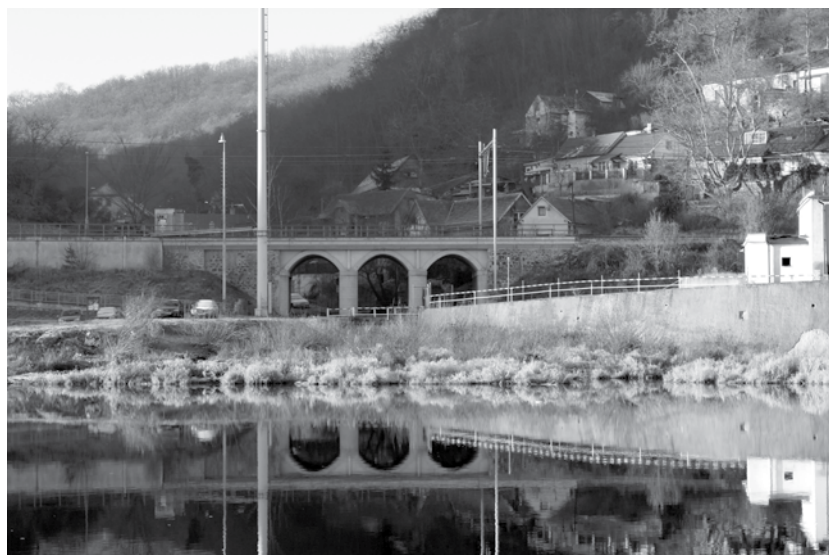
Pohled na podmoráňský viadukt
